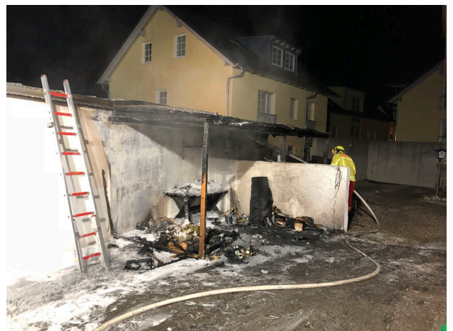
24.03.2018: Brand eines Unterstandes am Bahnhofplatz. Ein Übergreifen des Feuers auf angrenzende Garagen wurde verhindert.
