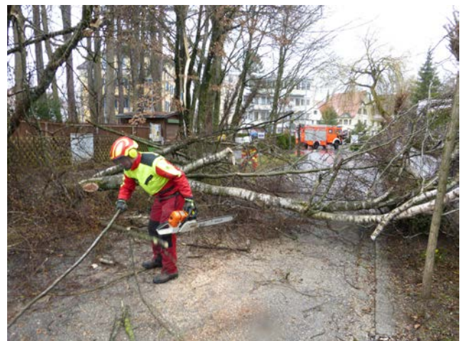
18.03.2017: Beseitigen eines umgestürzten Baumes in der Eichwaldstraße.
