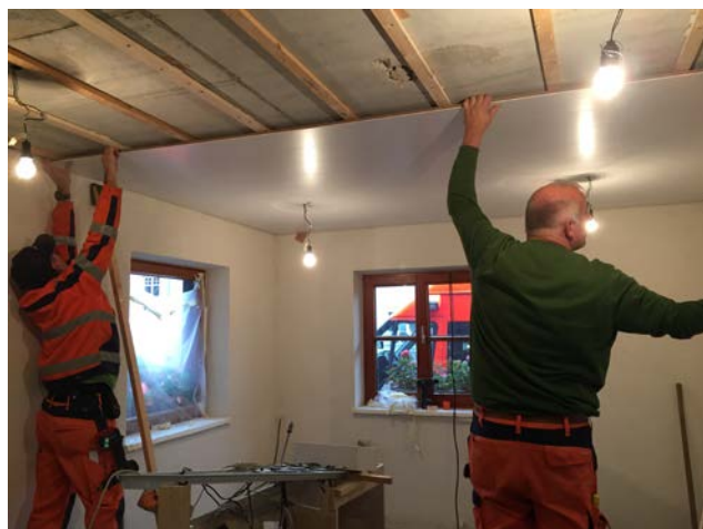
10.11.2017: Anbringen von Deckenelementen in der fast komplett entkernten Einsatzzentrale.
