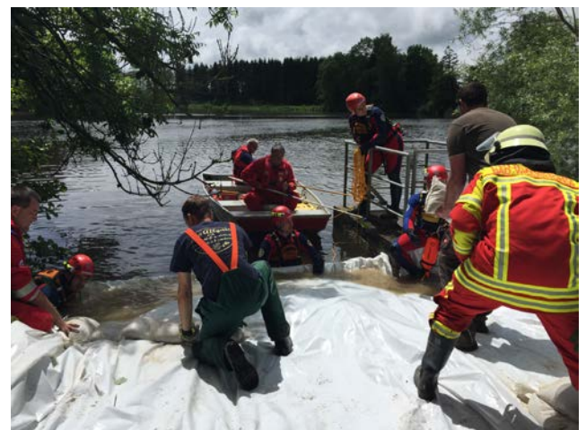
05.06.2016: Sicherung des Damms am Wald- see, der nach Starkregen bedrohlich angestiegen war.
