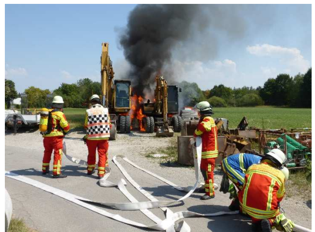
08.08.2015: Brand von zwei Baggern im Unteren Hart.
